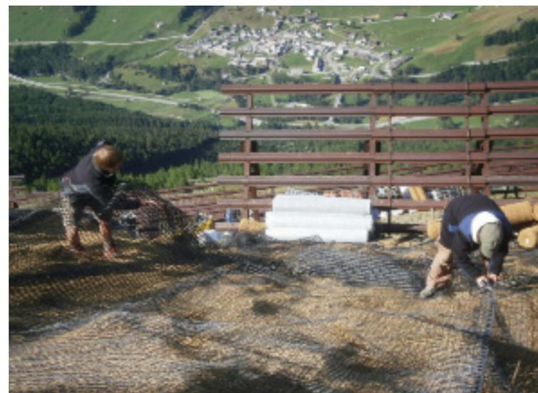
Verlegen von Erosionsschutzmatten in der Höhe von 2400 m ü. M.. Im Hintergrund Simplon Dorf 1600 m ü. M.
